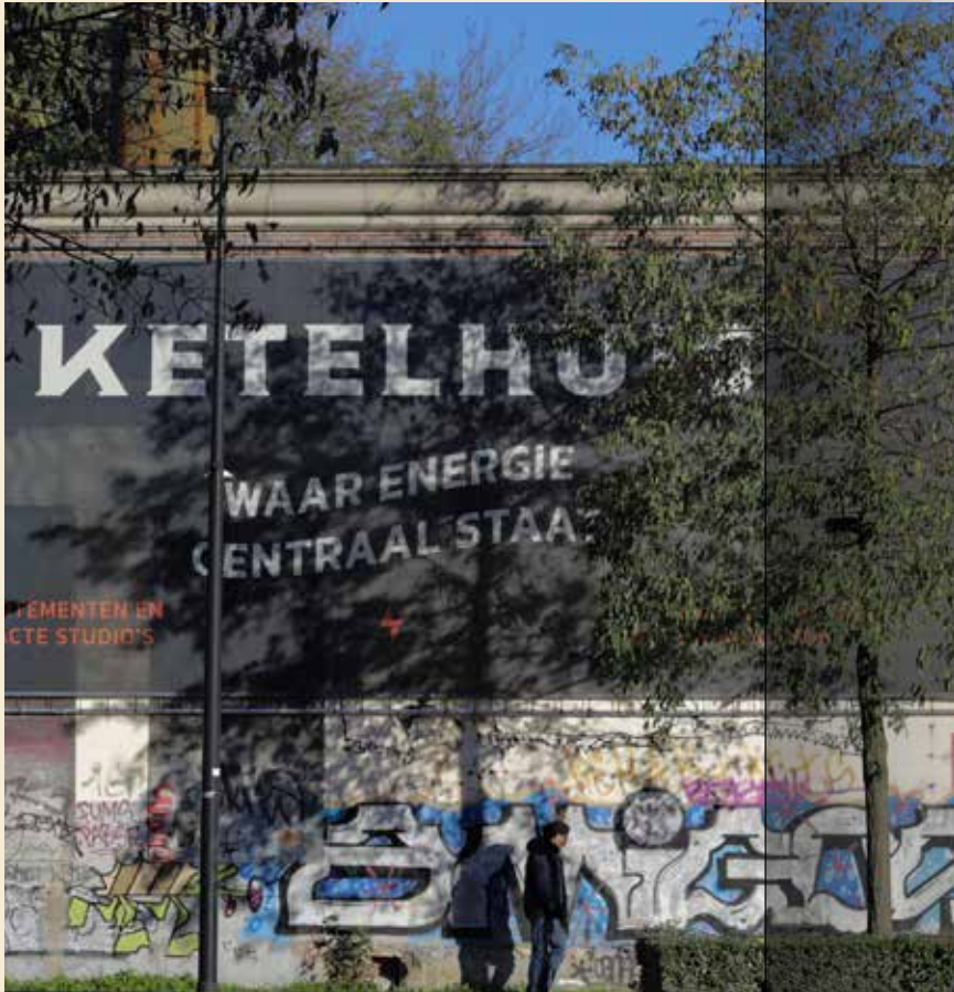
Het Ketelhuis verkeert in vervallen staat. | Foto Merel Uildriks
