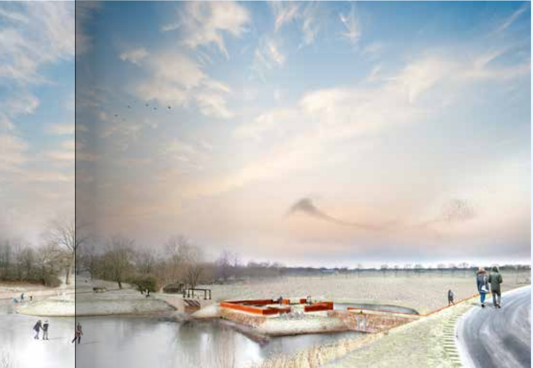
Visualisatie van de herstelde inundatiewerken van Fort Vuren. Bij extreem hoogwater stroomt water over de dijk de fortgracht in en wordt via de inundatiewerken afgevoerd naar de achtergelegen inundatievelden. | Beeld Veenenbos en Bosch i.o.v. Graaf Reinaldalliantie
